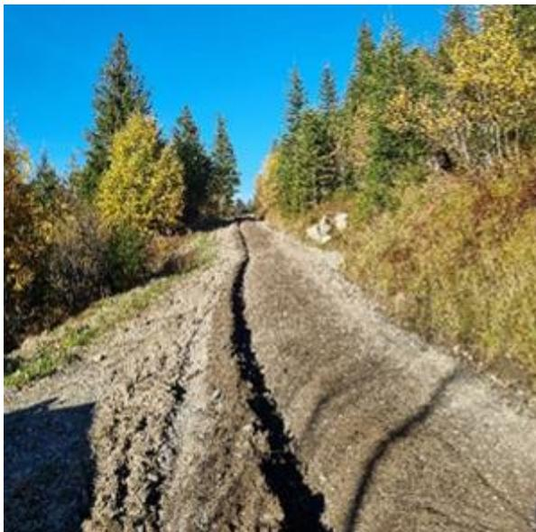
Abb: Material ab Zettenalp (0 – 150) vorgebrochen auf 0 – 50, bereit zum nachbrechen.
