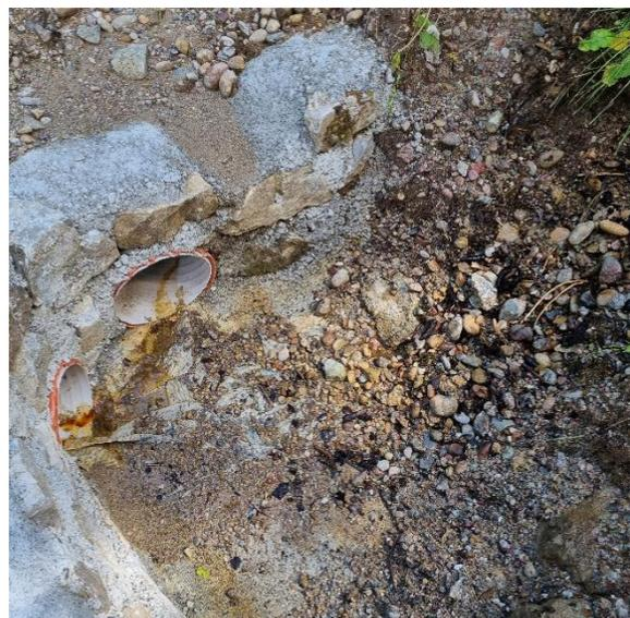
*Abb. Zufluss des früheren Durchlasses oben im Bild und neuer Strassendurchlass, links im Bild.*
