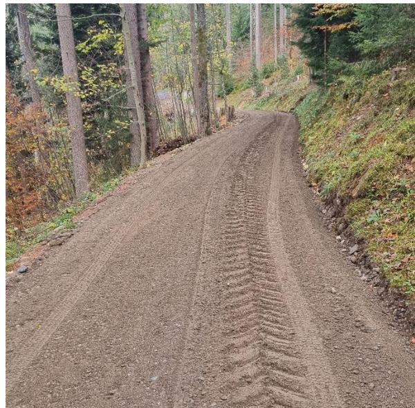
Abb: Fertig profilierte Strasse, bereit zum Verdichten.
