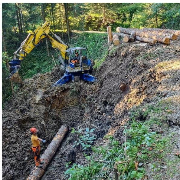
*Abb: Ausrichtung des ersten Querholzes auf der Nagelfluh-Sohle.*
