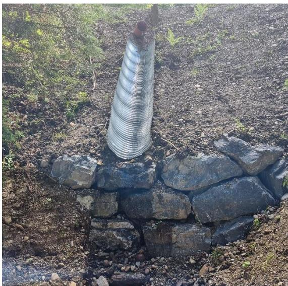
*Abb. Blocksteinmauer, neuer Durchlass und Halbschale unterhalb der Straße*
